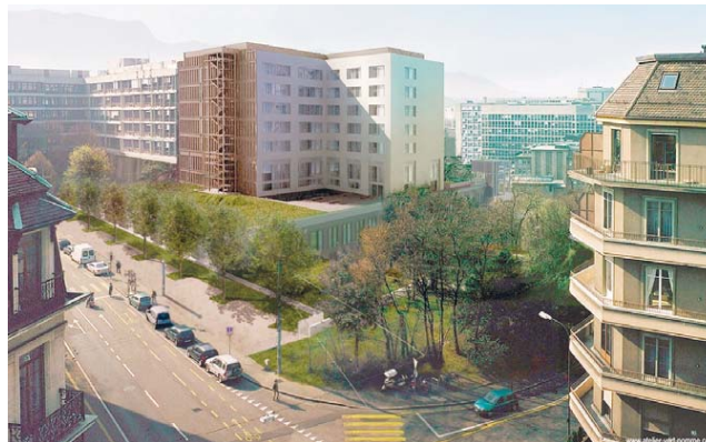
L'extension du CMU accolée au bâtiment existant, vue depuis l'avenue de Champel. Photographie de Planta & Portier architectes.
